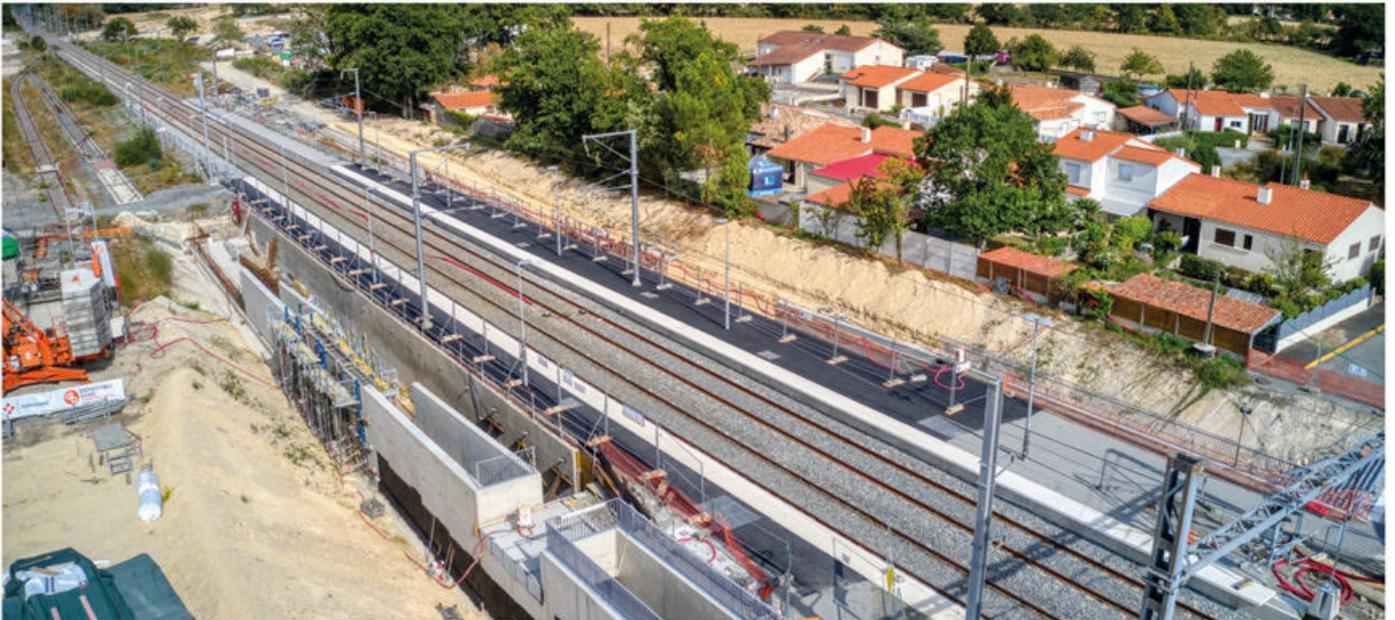
En gare, les travaux se poursuivent avec la mise en accessibilité des quais et des rampes d'accès avec le rehaussement et l'allongement des quais, la pose de dalles d'éveil à la vigilance, un éclairage LED, de la signalétique afficheurs... Livraison programmée en avril 2022.
