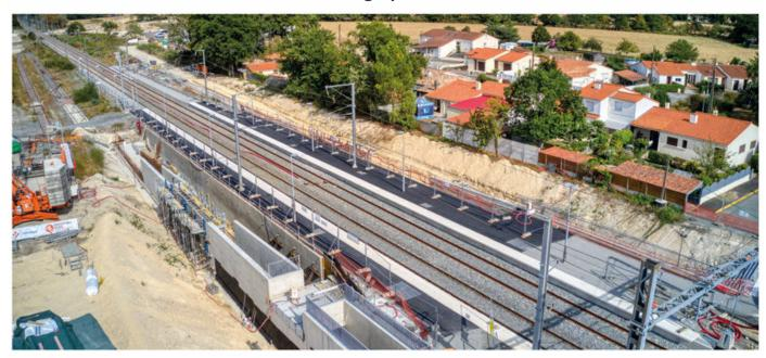
En gare, les travaux se poursuivent avec la mise en accessibilité des quais et des rampes d'accès avec le rehaussement et l'allongement des quais, la pose de dalles d'éveil à la vigilance, un éclairage LED, de la signalétique afficheurs... Livraison programmée en avril 2022.
