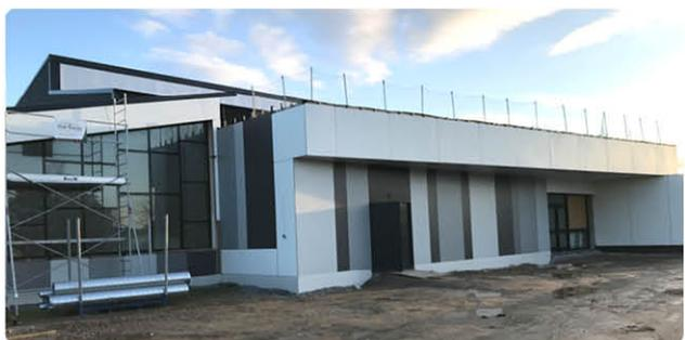
. **Avancement des travaux** : finition du bardage en cours, menuiseries extérieures posées, cloisonnement en cours, carrelage-faïence en cours, électricité, ventilation, peinture en cours...
